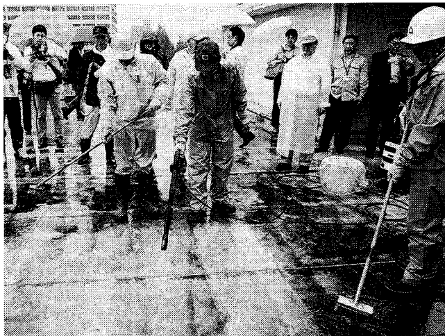
先月26日、福島市立第一小学校の屋上で、県職員らが洗浄機とデッキブラシを使って除染。どのくらい線量が減るかを調べた
